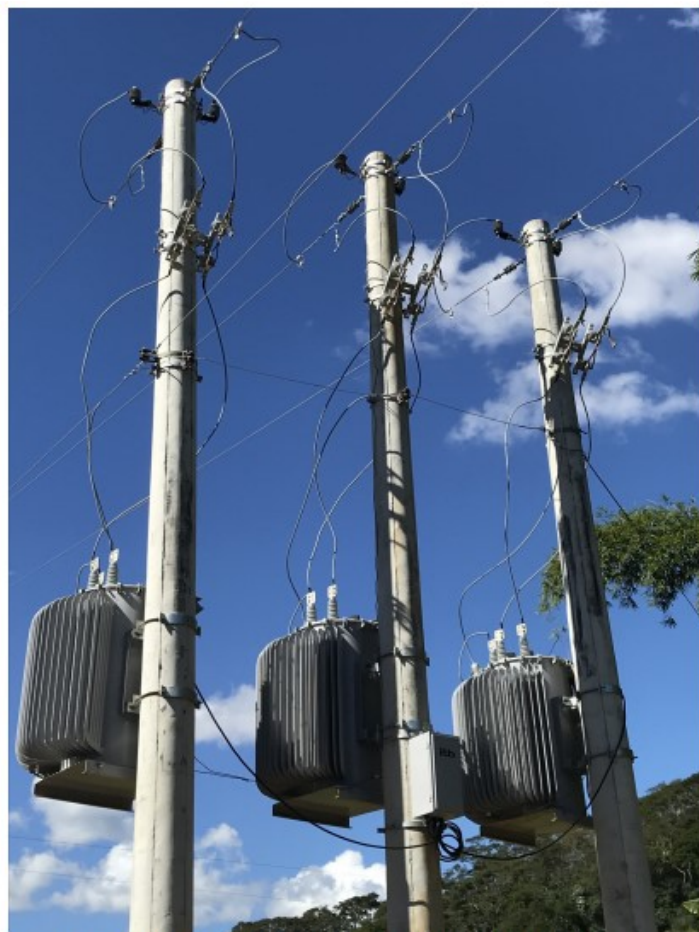
Figura 3: CDR instalado em campo com controle único CTX (visão traseira)
